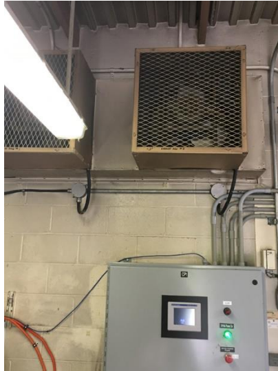
Figure 43: Exhaust Fan Unit
